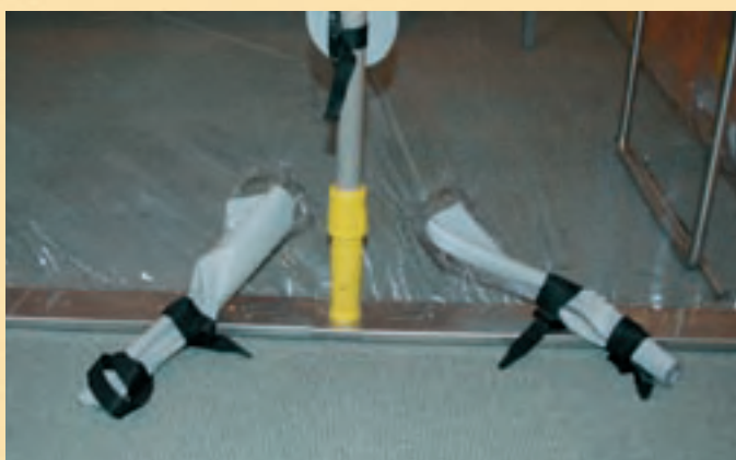
Uszczelnienie wprowadzenia instalacji do wewnątrz komory
